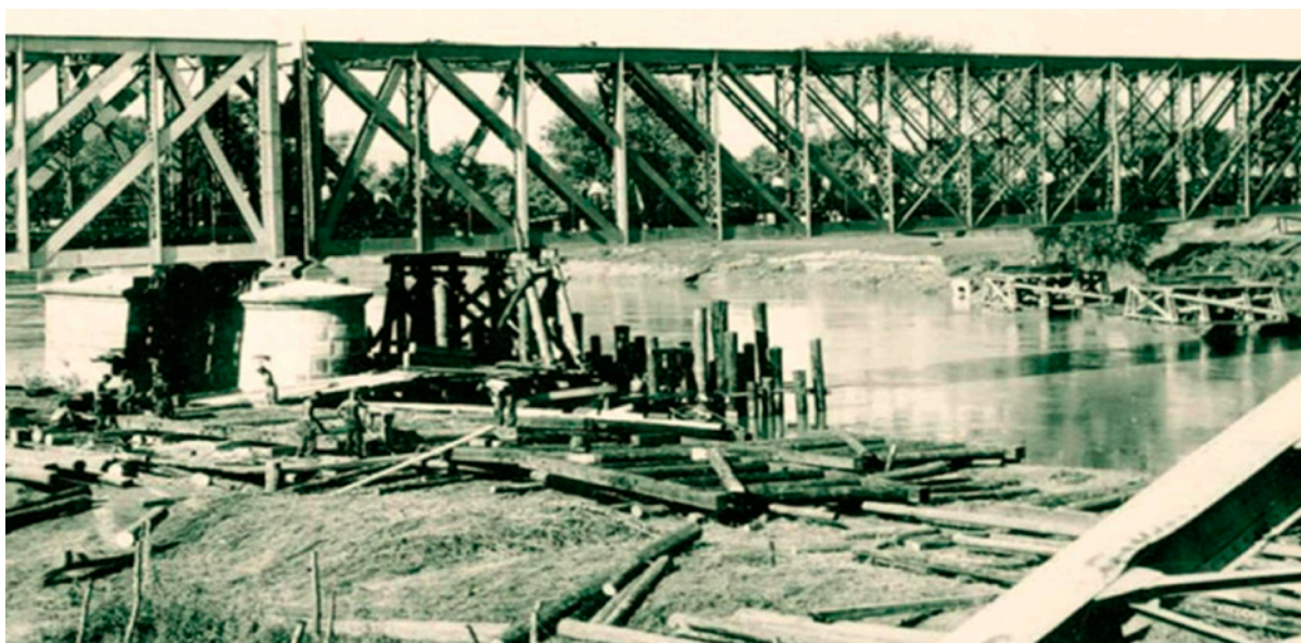
Fig. 10. Podul feroviar peste r. Prut, în reparație după bombardamentul din 1941. Foto de epocă (după: https://www.history.ro/sectiune/general/articol/podul-pest-prut-proiectat-si-construit-de- ).
